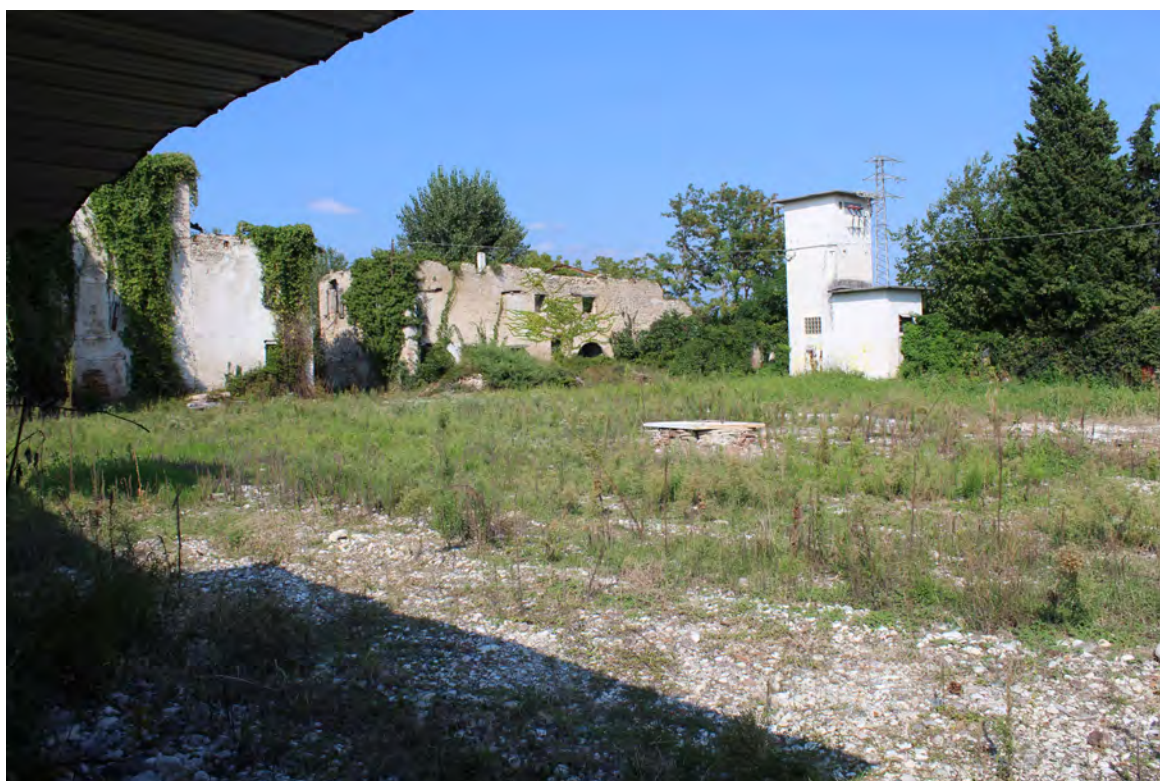
Fig. 19 – Scatto 27. Vista dell'area dall'interno da Est .
