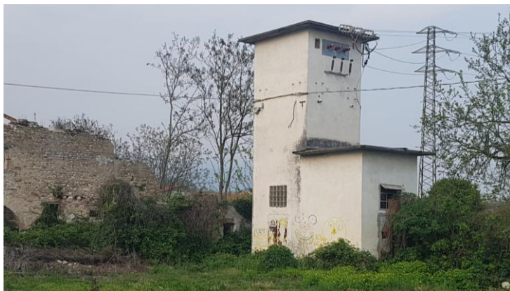
Foto della cabina dell'Enel presente all'interno della proprietà
